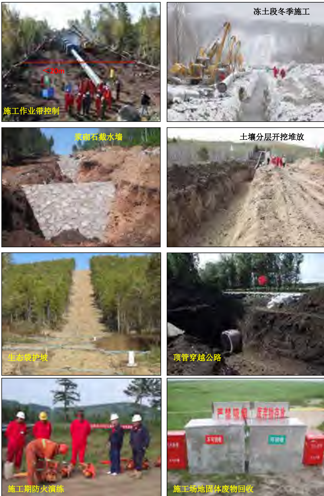
图 2.3-1 工程施工期部分环保措施
