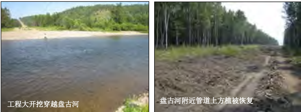
图 2.3-2 盘古河自然保护区境内的管道
