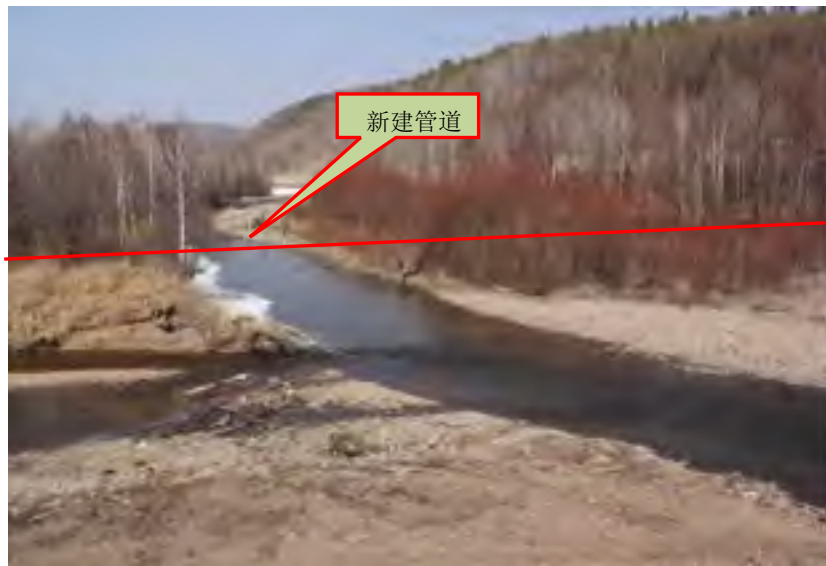
图 12.4-17 西里尼西河穿越位置地貌
