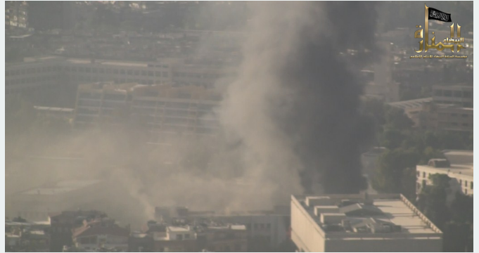
احتراق المبنى بسبب التفجير الثاني من الخارج ويفعل المجاهدين في الداخل
