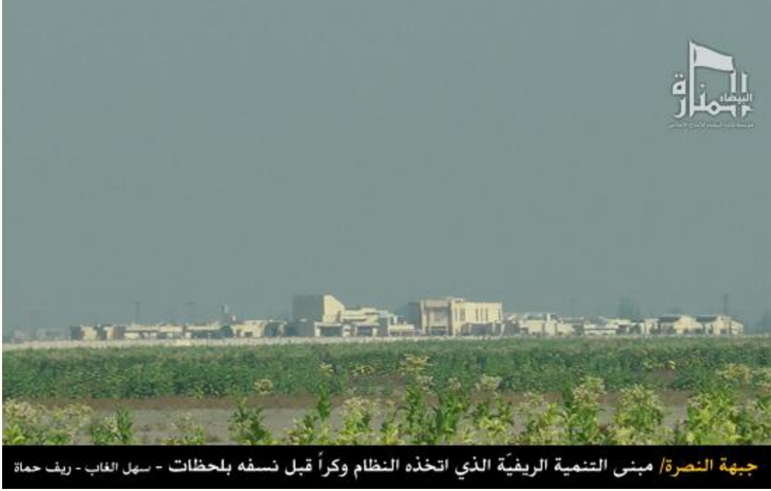
[صورة: المبنى قبل نسفه]
